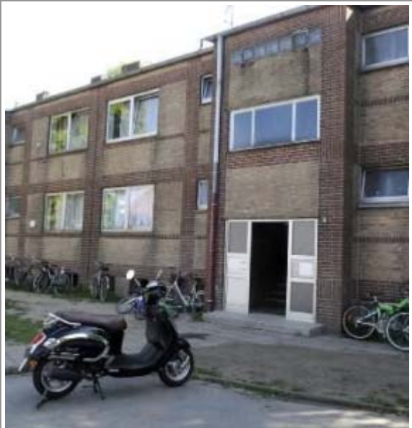
Dieses Gebäude „Am Reinersbach“ zur Unterbringung von Flüchtlingen soll durch einen Neubau ersetzt werden.
