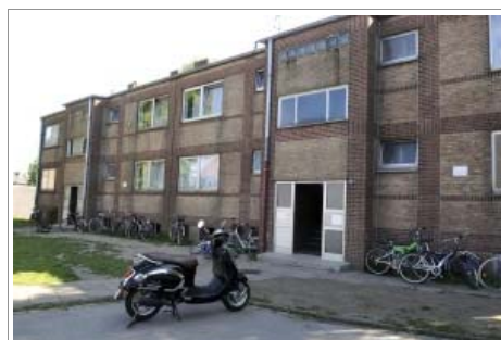
Die Asylbewerberunterkunft am Reinersbach ist stark sanierungsbedürftig.
