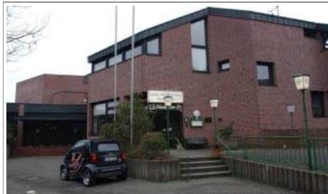
Für die Albert-Mooren-Halle in Oedt stehen noch Sanierungen an.
